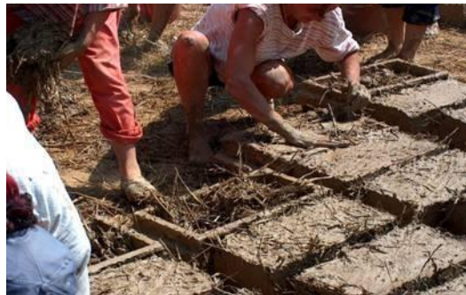
Resim 1.9: Kerpiçin yapılışı
