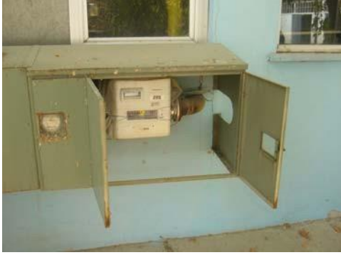
Şekil 3.5: Sayaçların muhafaza içine alınması
