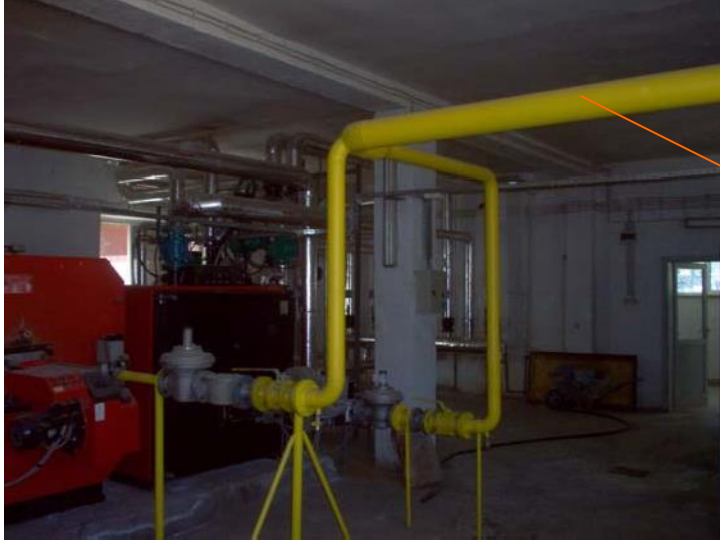
Resim 3.5: Kazan gaz besleme boru hattı
