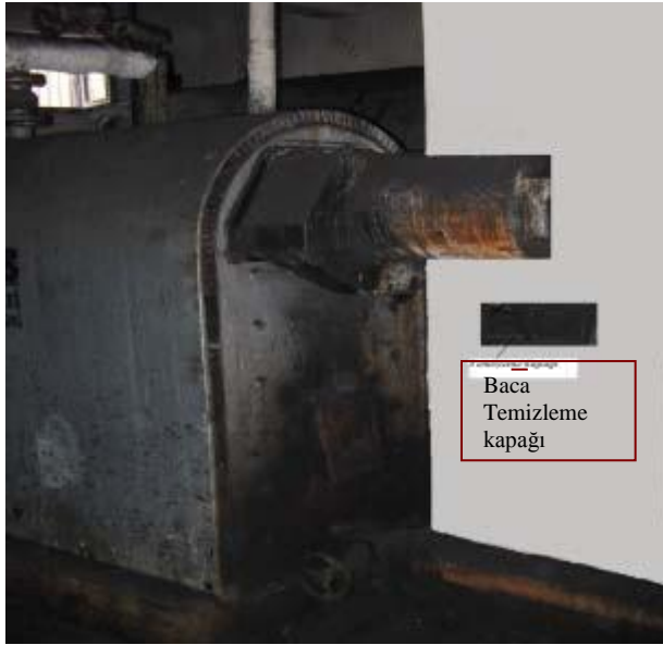
Resim 4.1: Kazan baca bağlantısı ve baca alt kısmında bulunan temizleme kapağı yeri
