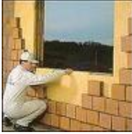
Resim 1.4: Tuğla ve taş duvar
